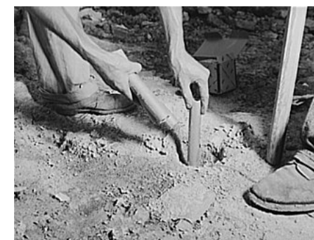
Вставка динамита в шпур при постройке дамбы Дуглас-Дэм, Теннесси, июнь 1942.
