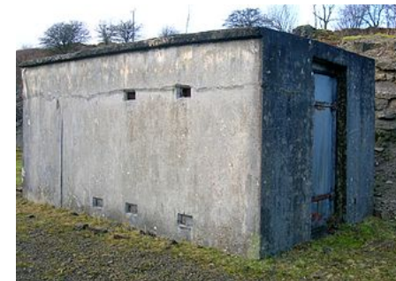
Типичное старое бетонное здание для хранения динамита и детонаторов, Шотландия
